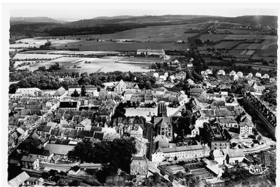
Vue aérienne des années 30. Au premier plan la gare et la Poste sur le glacis Ouest, au second plan l'hôpital sur le bastion Royal.
