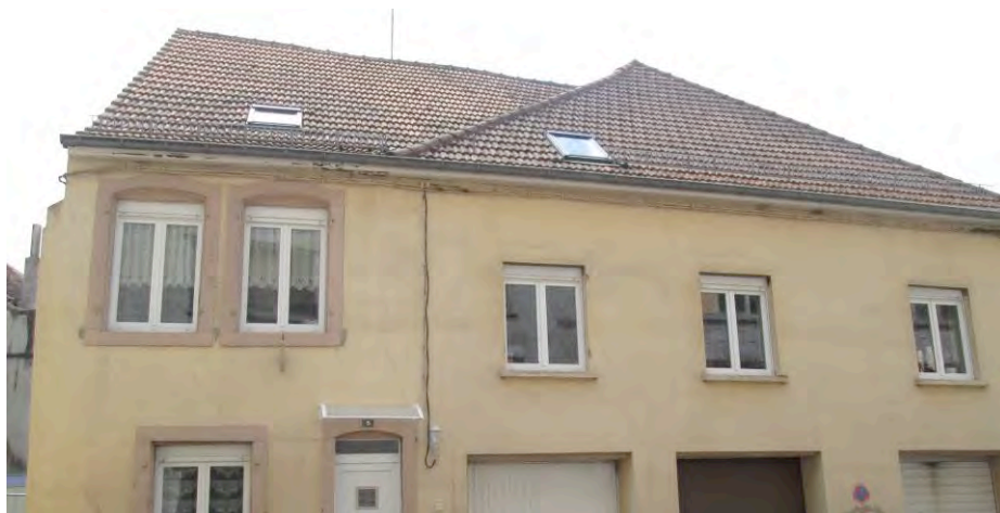
Exemple de menuiseries PVC et de caissons de volets roulants apparents
