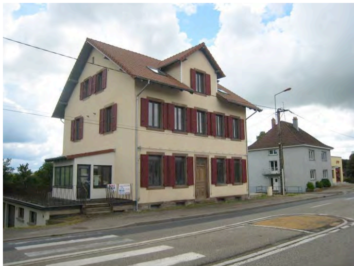
Maison de la première moitié du XXème siècle sur la Route de Sarrebourg
