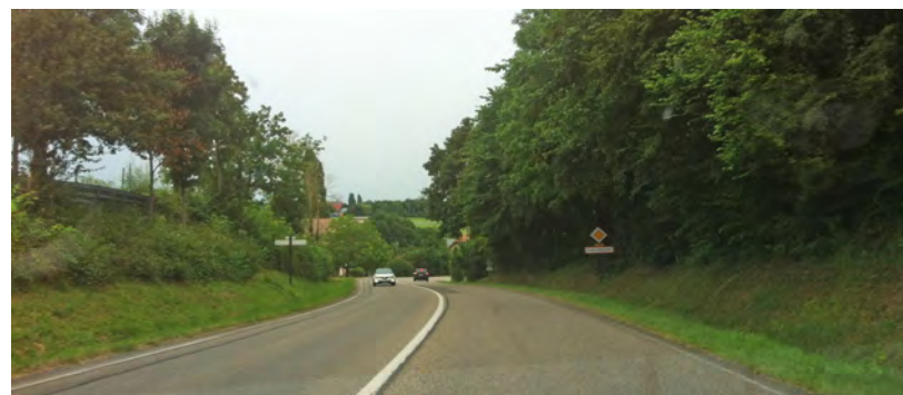
La section de voirie en creux depuis l'entrée de ville Ouest : les talus arborés cadrent la vue.
