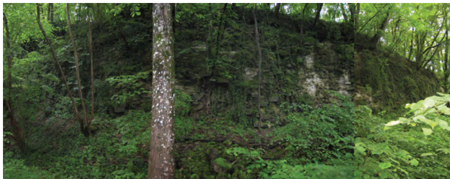
Les fortifications Est : le bastion s'élève à une dizaine de mètres au dessus du niveau des fossés.
