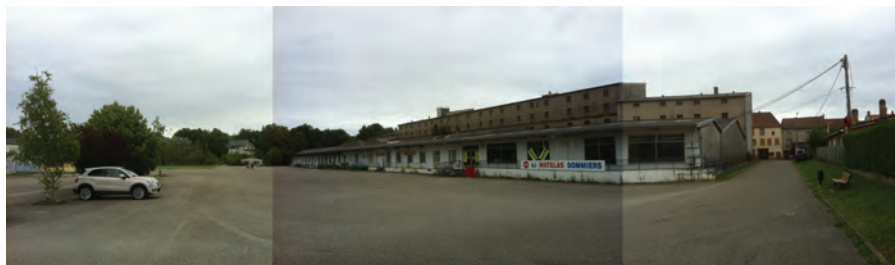
L'imposante aire de stationnement, les anciens quais de déchargement et la caserne Nord en arrière-plan..
