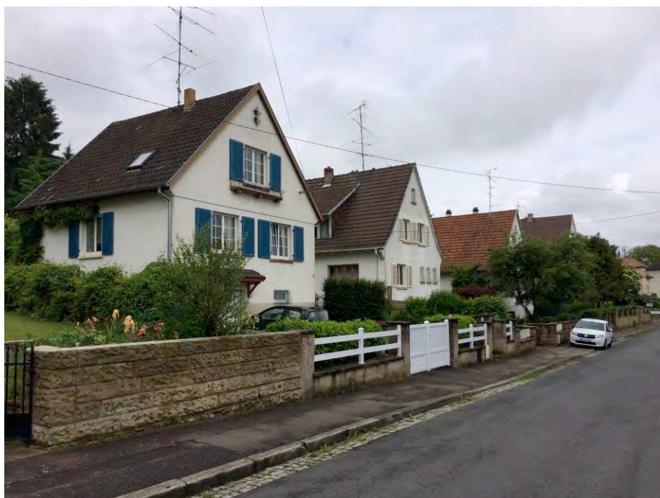
Lotissement de maisons de l'entre-deux-guerres
