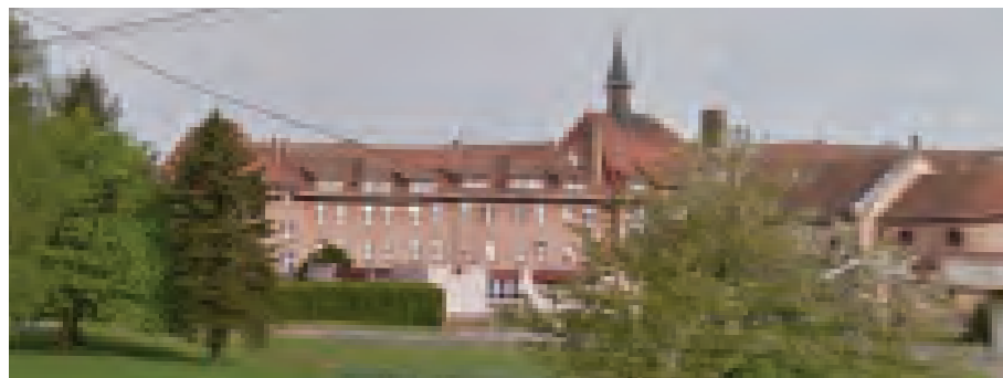
Le collège-lycée Saint Antoine est un signal fort dans le paysage.
