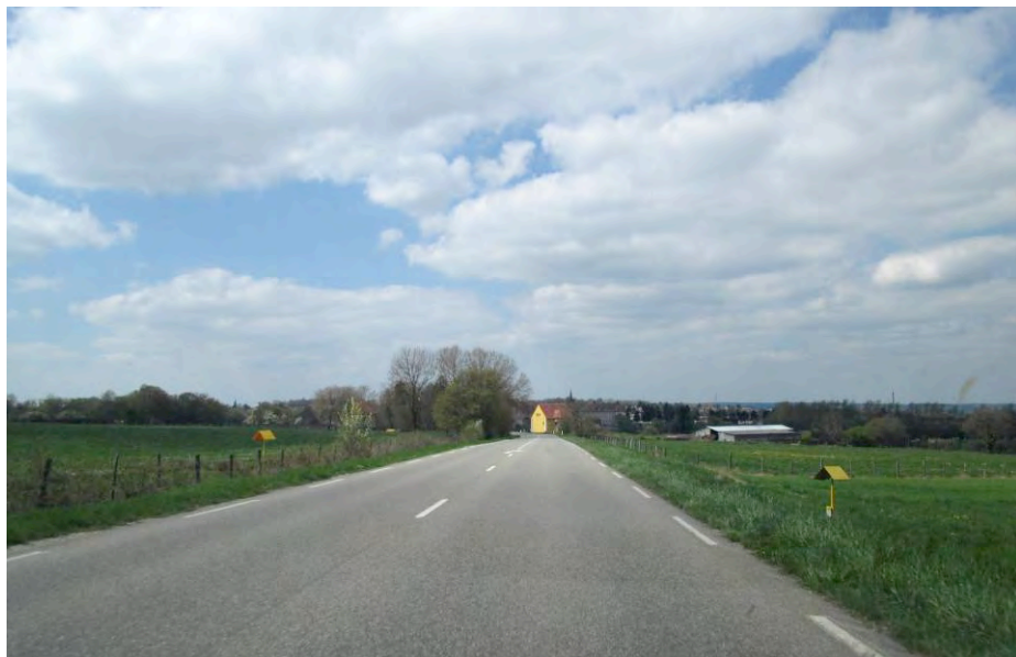
Route de Saverne - Entrée de la commune
