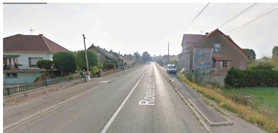
Vue de l'entrée Est par la RD604 (Source Google) - Route de Sarrebourg
