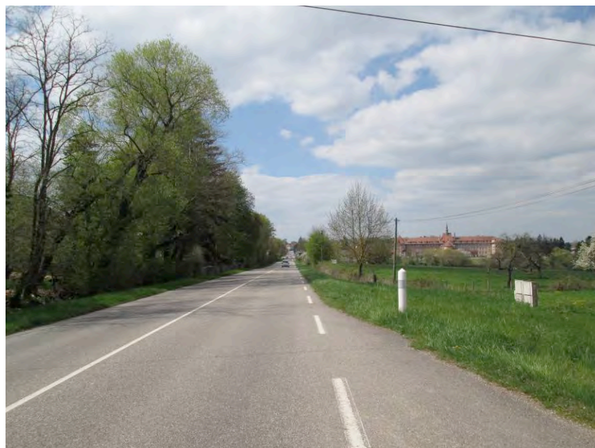
Route de Saverne - Vue vers l'Ouest, à droite le Collège Saint Antoine
