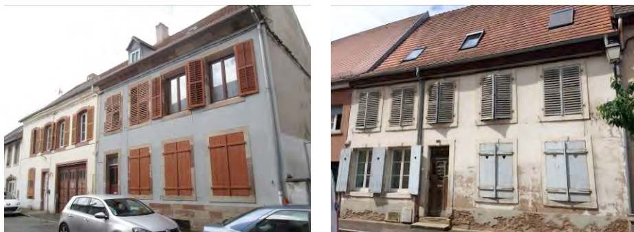
Exemples de volets pleins en RDC
