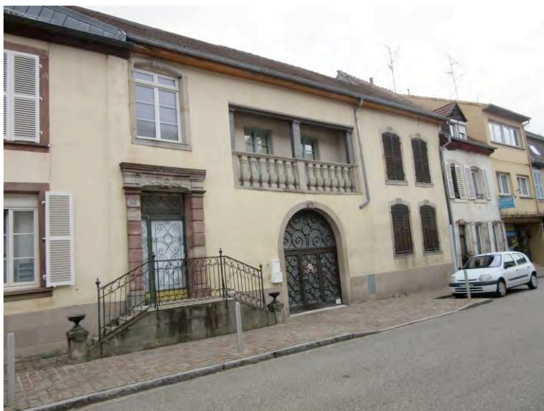
Exemples d'escaliers à rampe avec garde-corps et mur d'échiffre
