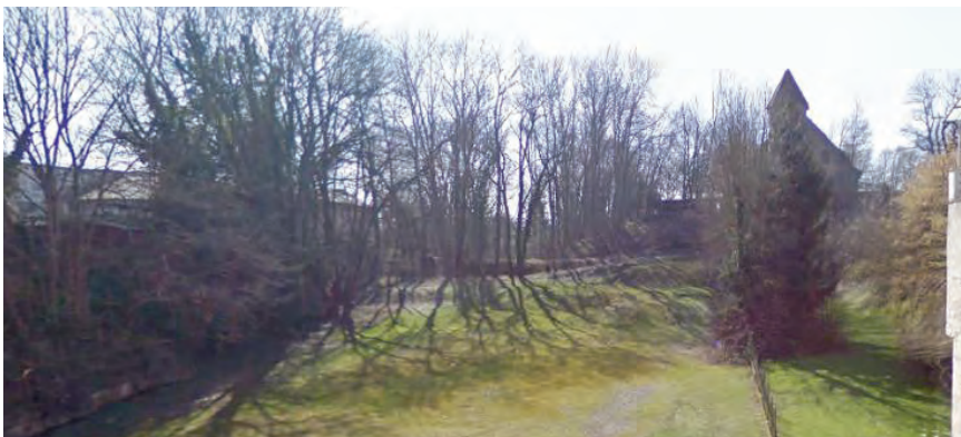
Vue comparatives été/hiver sur le fossé Ouest vers le bastion n°04 du « Château » et le fossé attenant.
