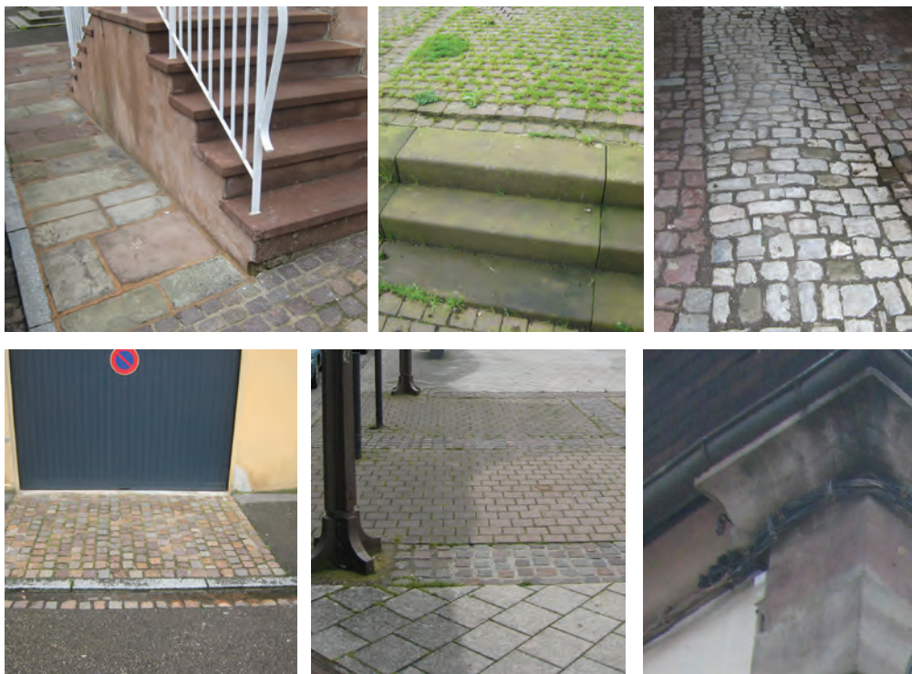
Exemple de traitements de sol en pierres naturelles rencontrés au centre ville : bordures granit, enmarchements, dalles et pavés grès des Vosges, pavés calcaires, pavés porphyre et béton. Réseaux aériens discrètement fixés en façade
